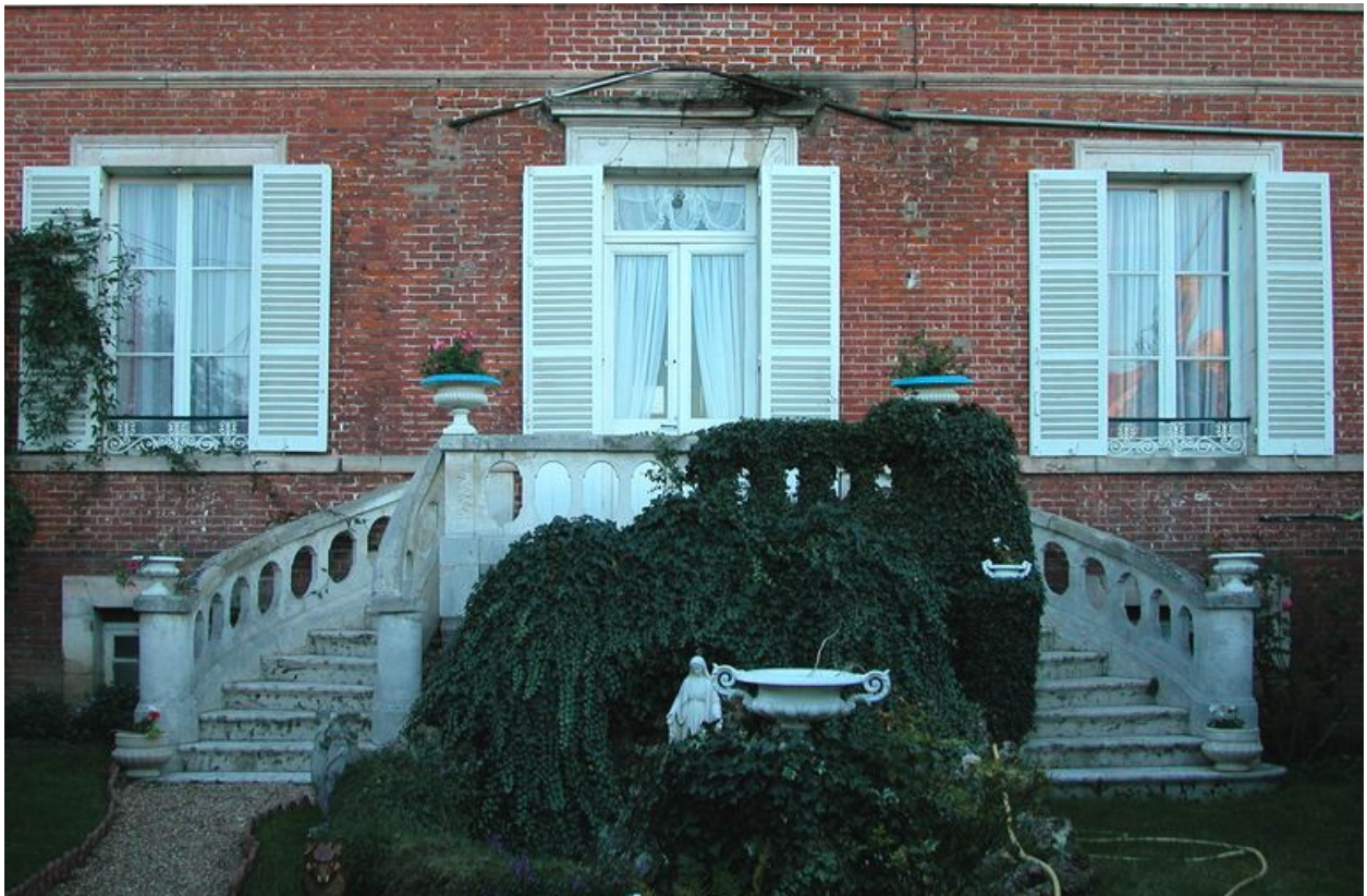
Logement patronal, détail du perron d'entrée, façade est.
