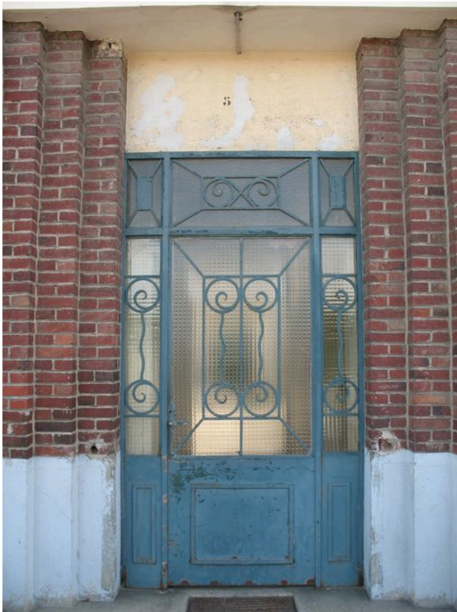
Bâtiment 520 : Porte d'entrée.
