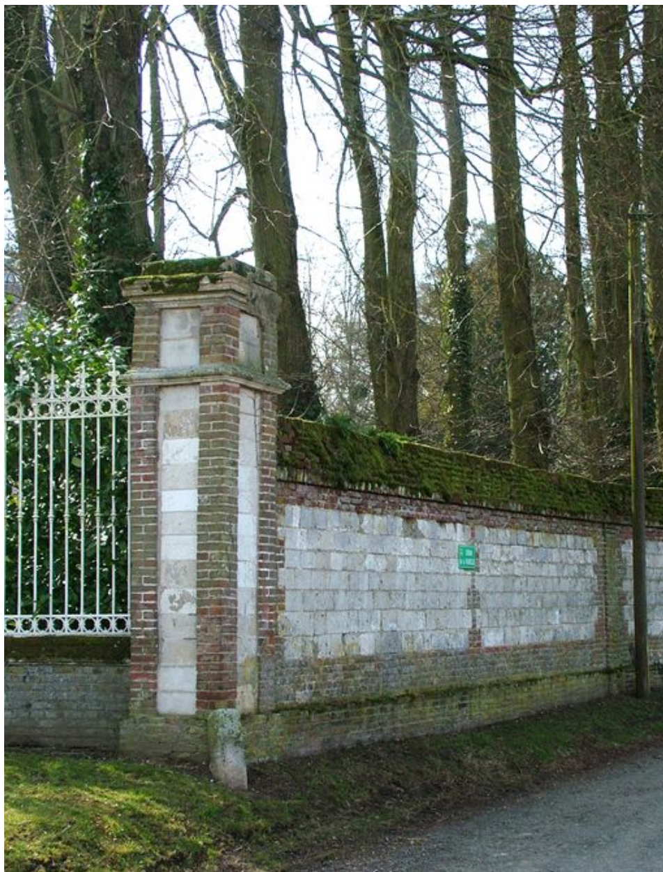
Vue partielle du mur de clôture prolongeant le portail en bordure de la route de Vignacourt.
