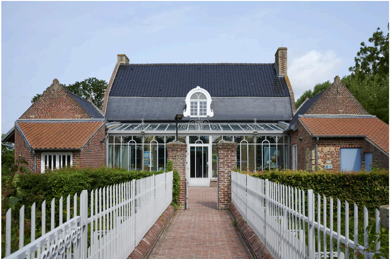
Vue du bâtiment depuis le pont.
