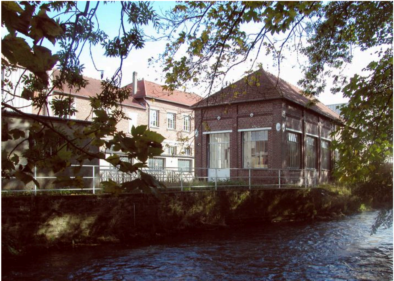
Vue d'ensemble depuis la rivière de l'atelier de décorage et de préparation des montures.
