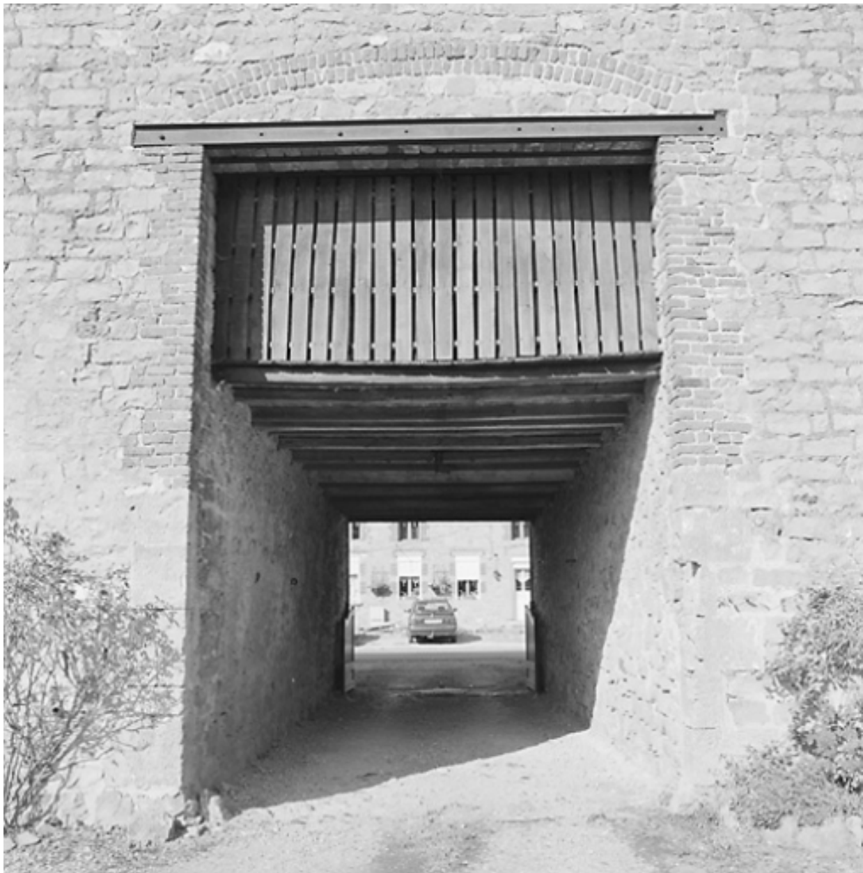
Vue du passage chartier, depuis la cour.
