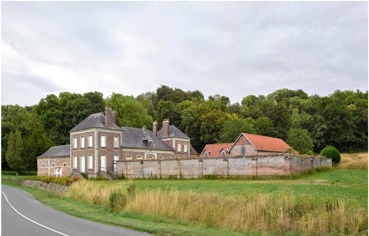
Vue générale de la ferme Jourdain, prise depuis le nord-ouest.
