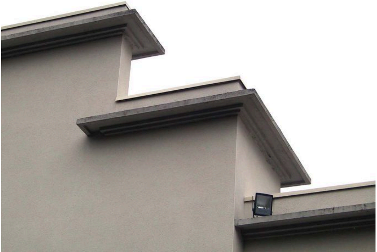
Façade arrière, avant-corps central, détail : traitement des rampants du fronton.
