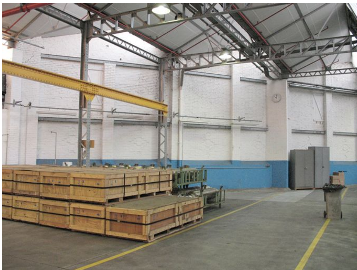
Partie des ateliers construits en 1893 pour Voirin.
