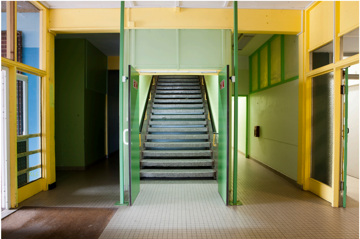
Escalier intérieur externat (lycée puis collège), rez de chaussée, 2016 (détruit en 2016).
