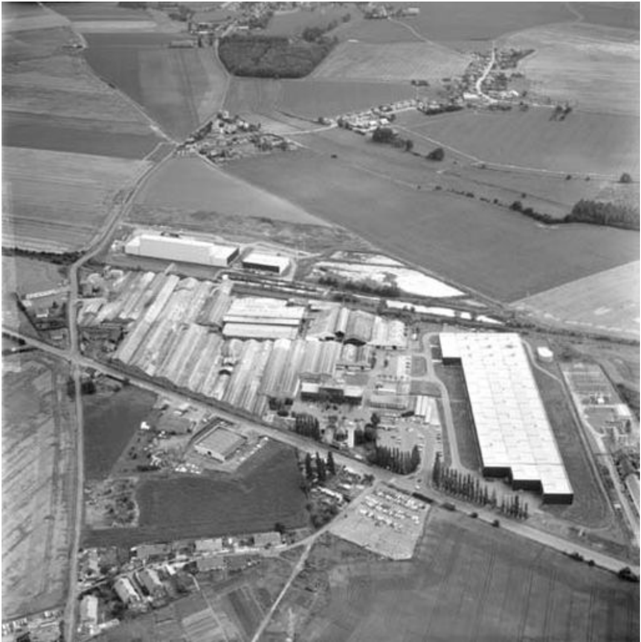
Vue aérienne, flanc nord.
