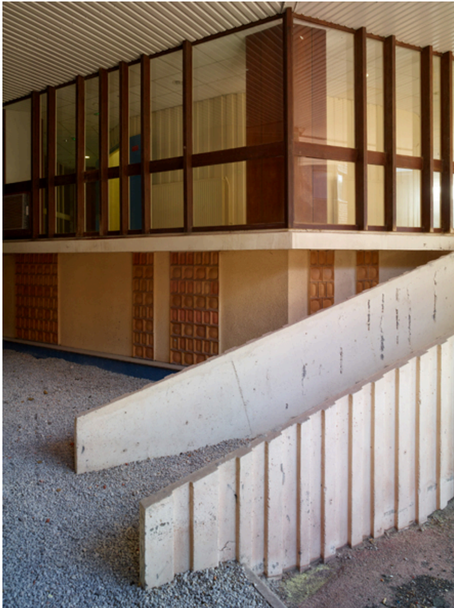
Vue extérieure du niveau de la plate-forme de la tour d'internat et du départ de la rampe d'escalier extérieure, depuis l'ancien patio d'accueil.
