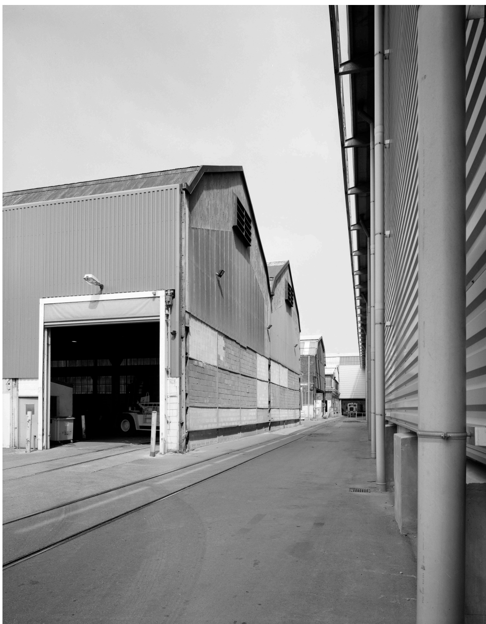
Vue générale des halles.
