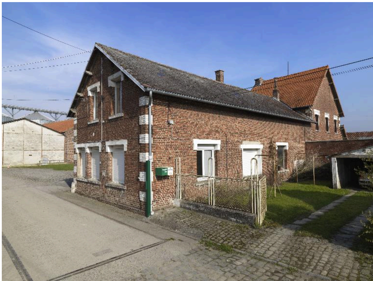
Les bureaux, vue d'ensemble sud-ouest.
