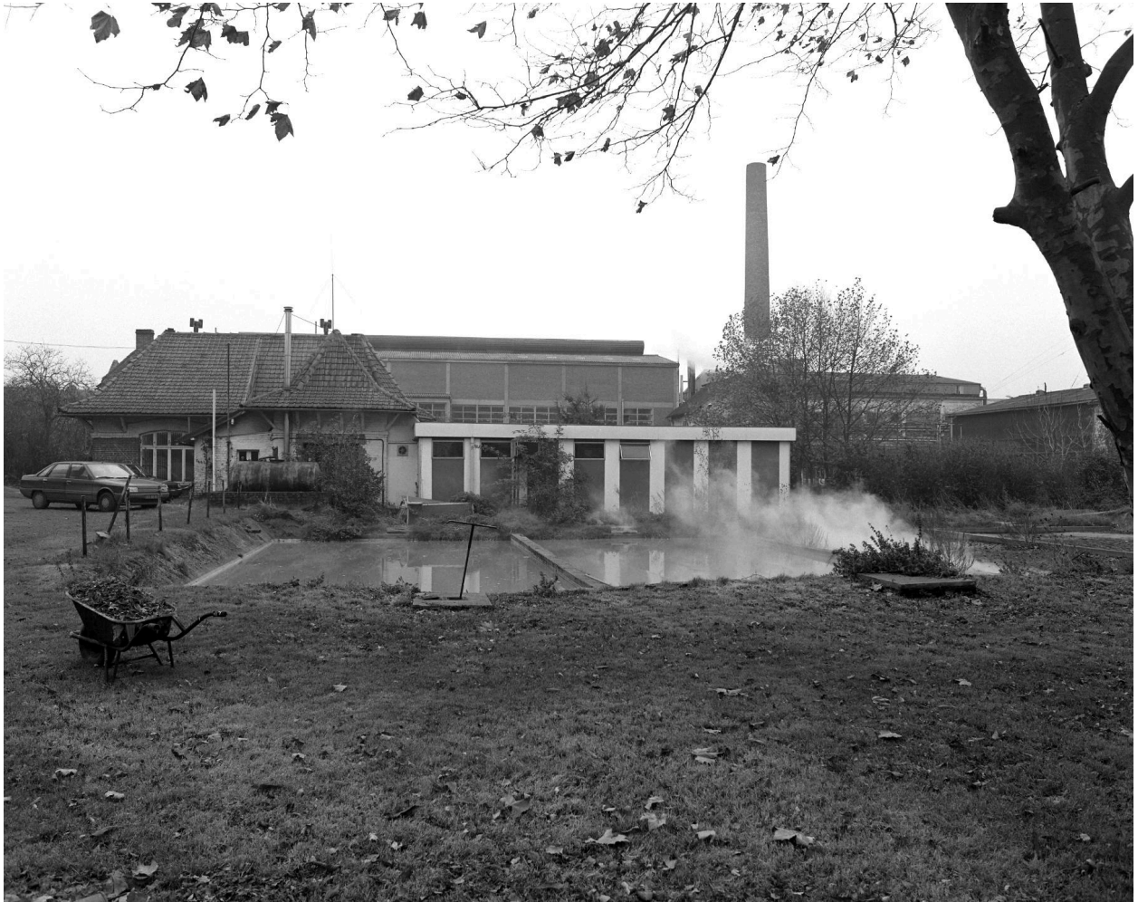
Bassin de décantation et bureaux. Vue prise vers l'est.
