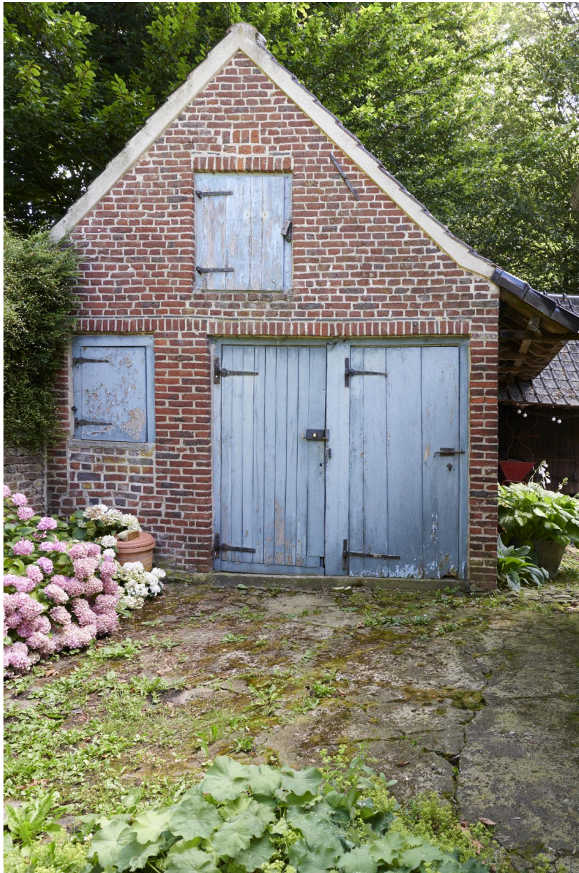
Ancien lavoir, pignon ouest.
