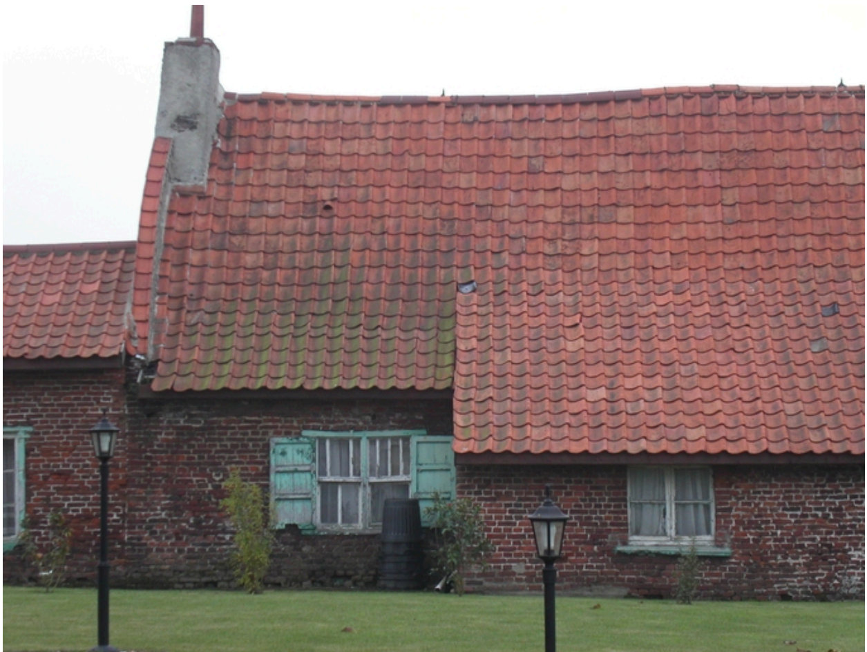
Détail de la façade postérieure du logis ; huisserie à croisée de bois.
