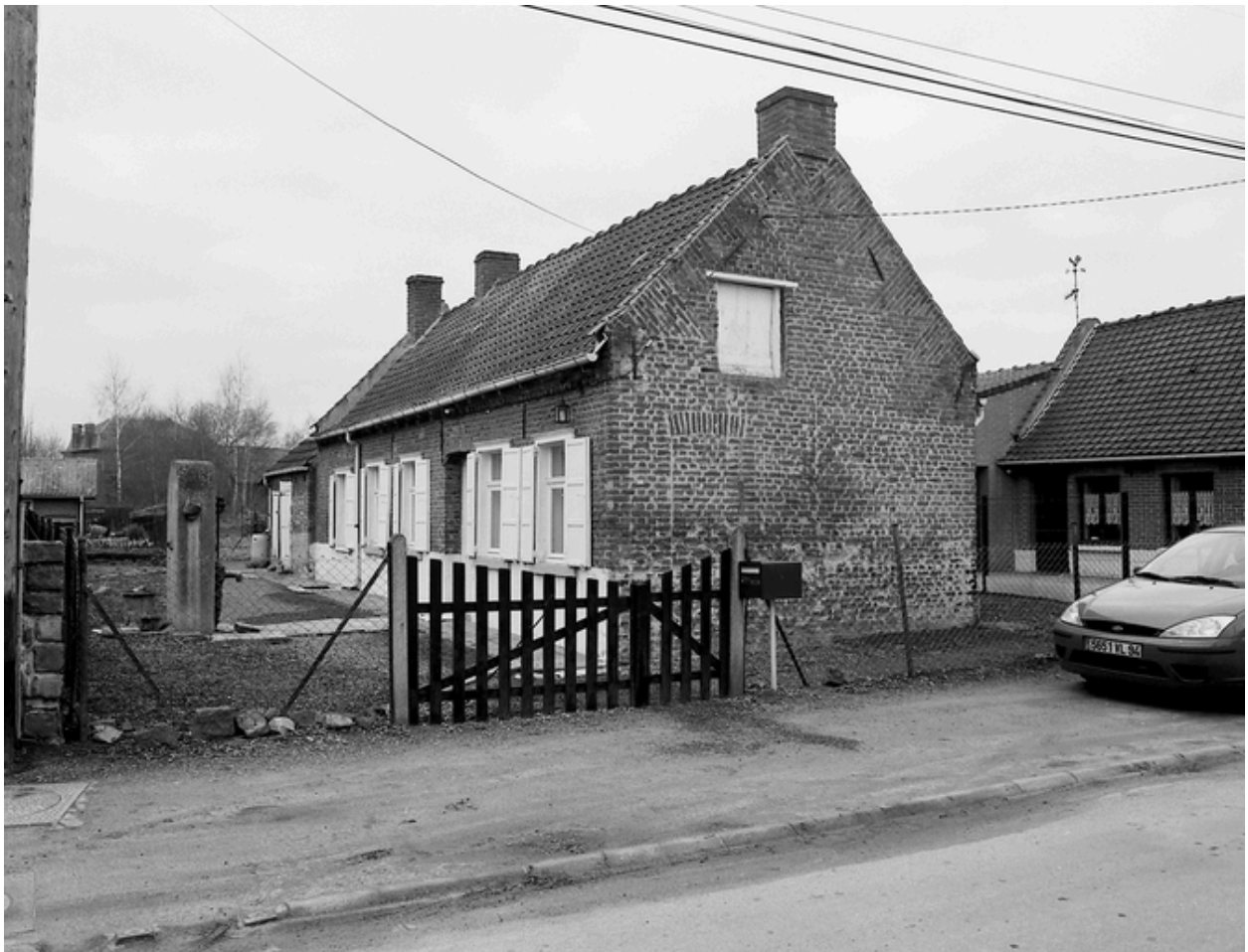
Maisons élémentaire, rue de la Lombarderie.
