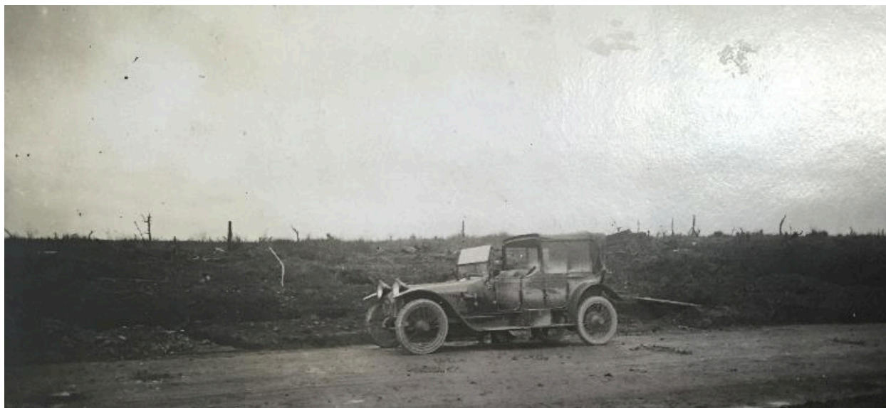
Vue de l'emplacement de l'usine, 5 décembre 1918 (AD Somme ; 10 R 343).
