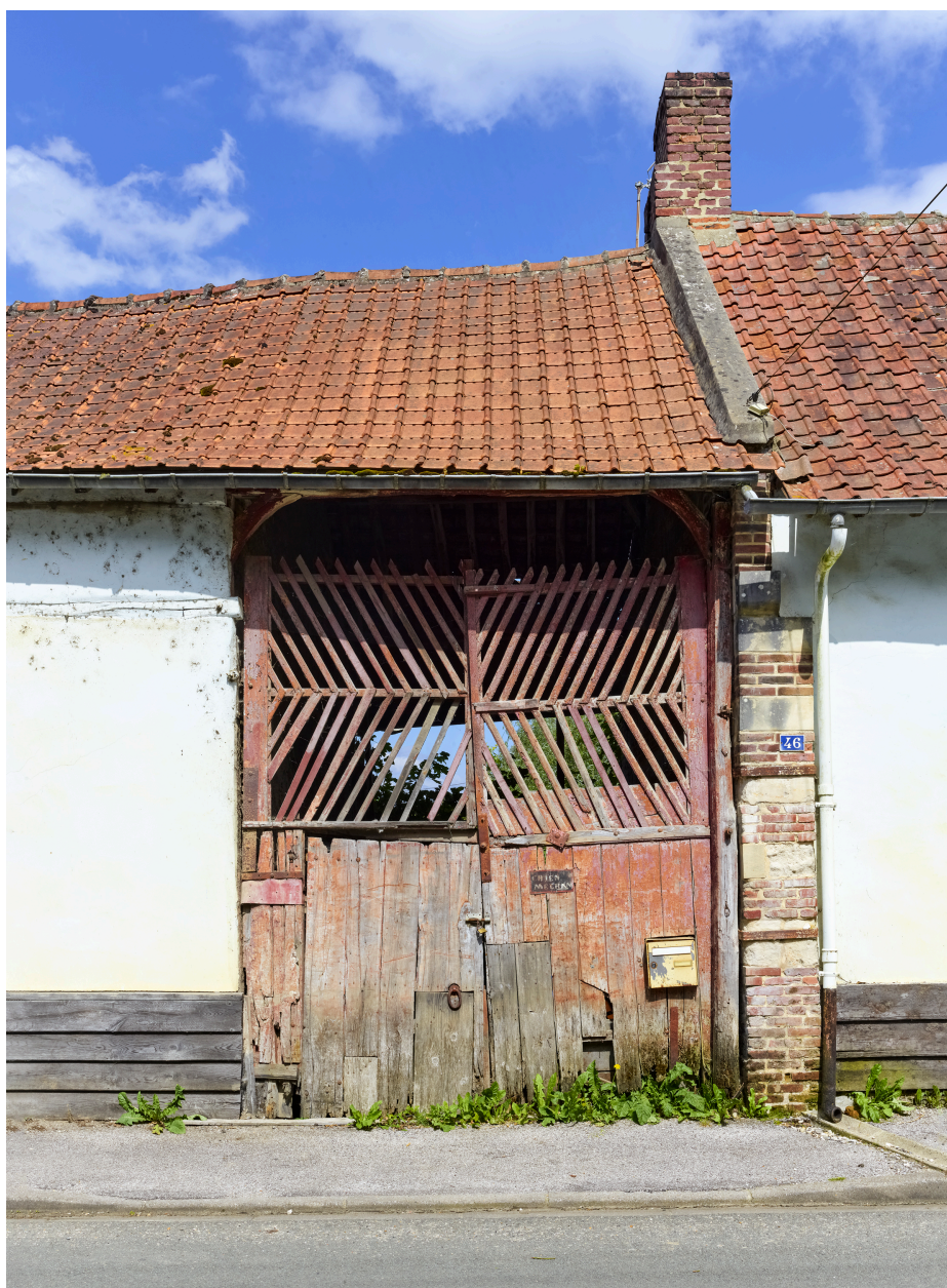
Détail de la porte charretière, depuis l'ouest.
