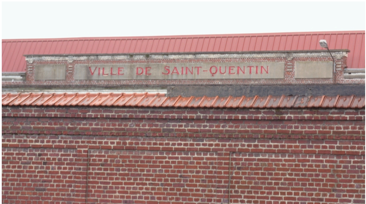
Mur de clôture (premier plan) et abattoir des bovins (arrière-plan).
