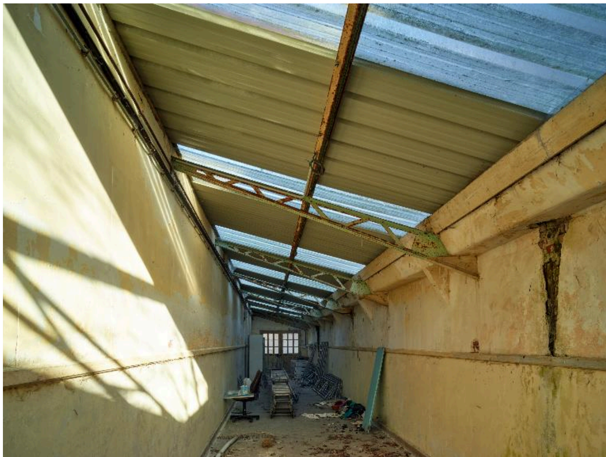
Galerie de communication couverte qui longe le mur de clôture postérieure du jardin du bâtiment de malades dit pavillon 6, vue en enfilade.
