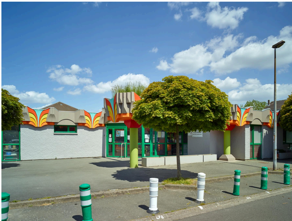
L'entrée du groupe scolaire, donnant sur la rue Jacques-Prévert.
