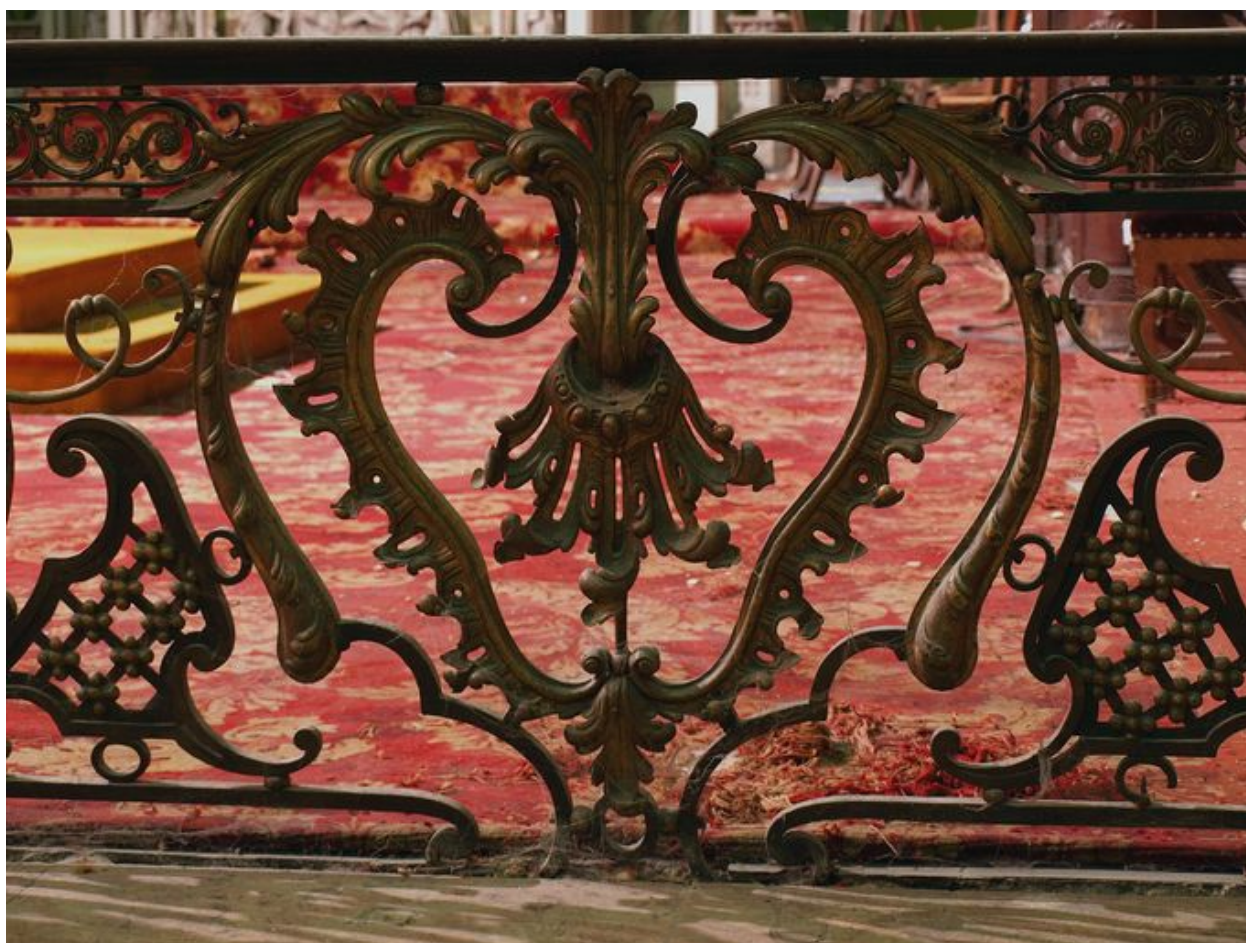
Vue de détail, décor, partie centrale
