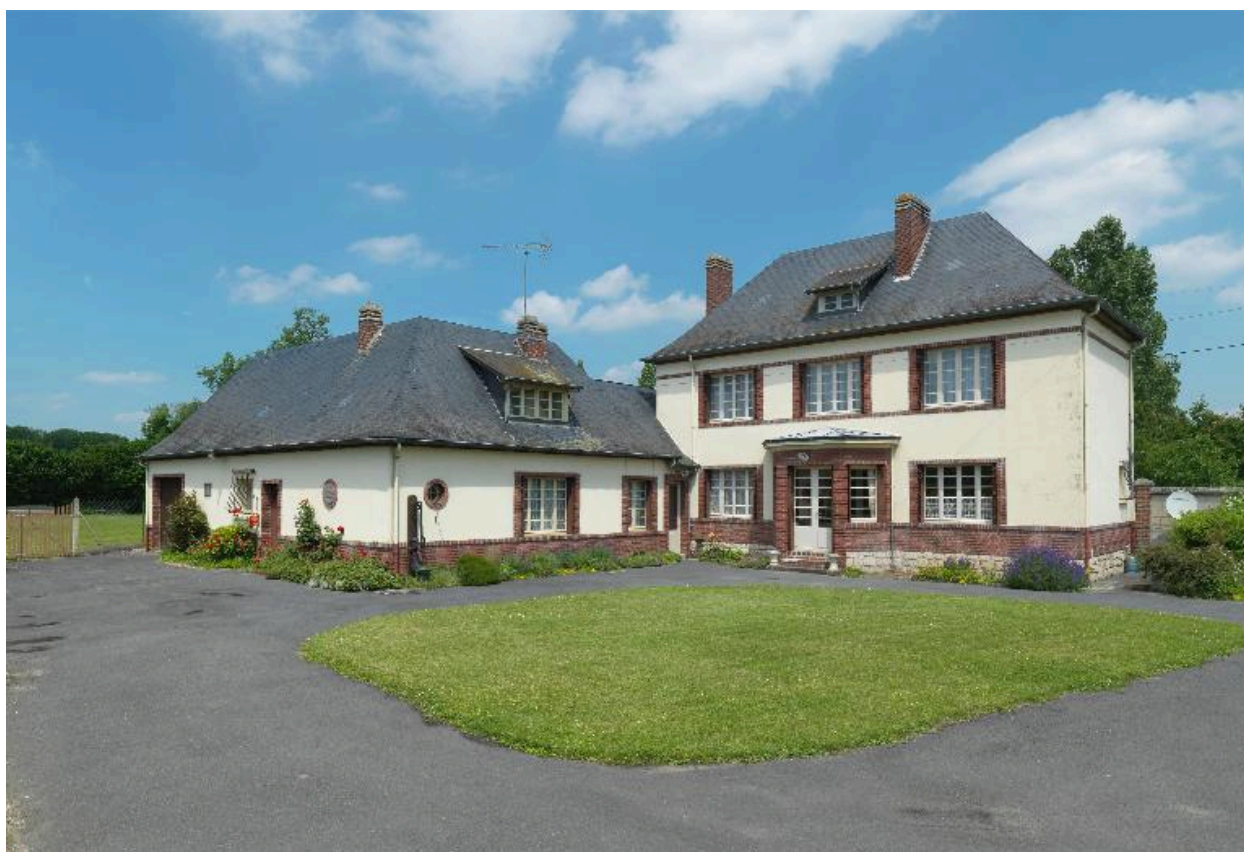
Vue d'ensemble sur cour.
