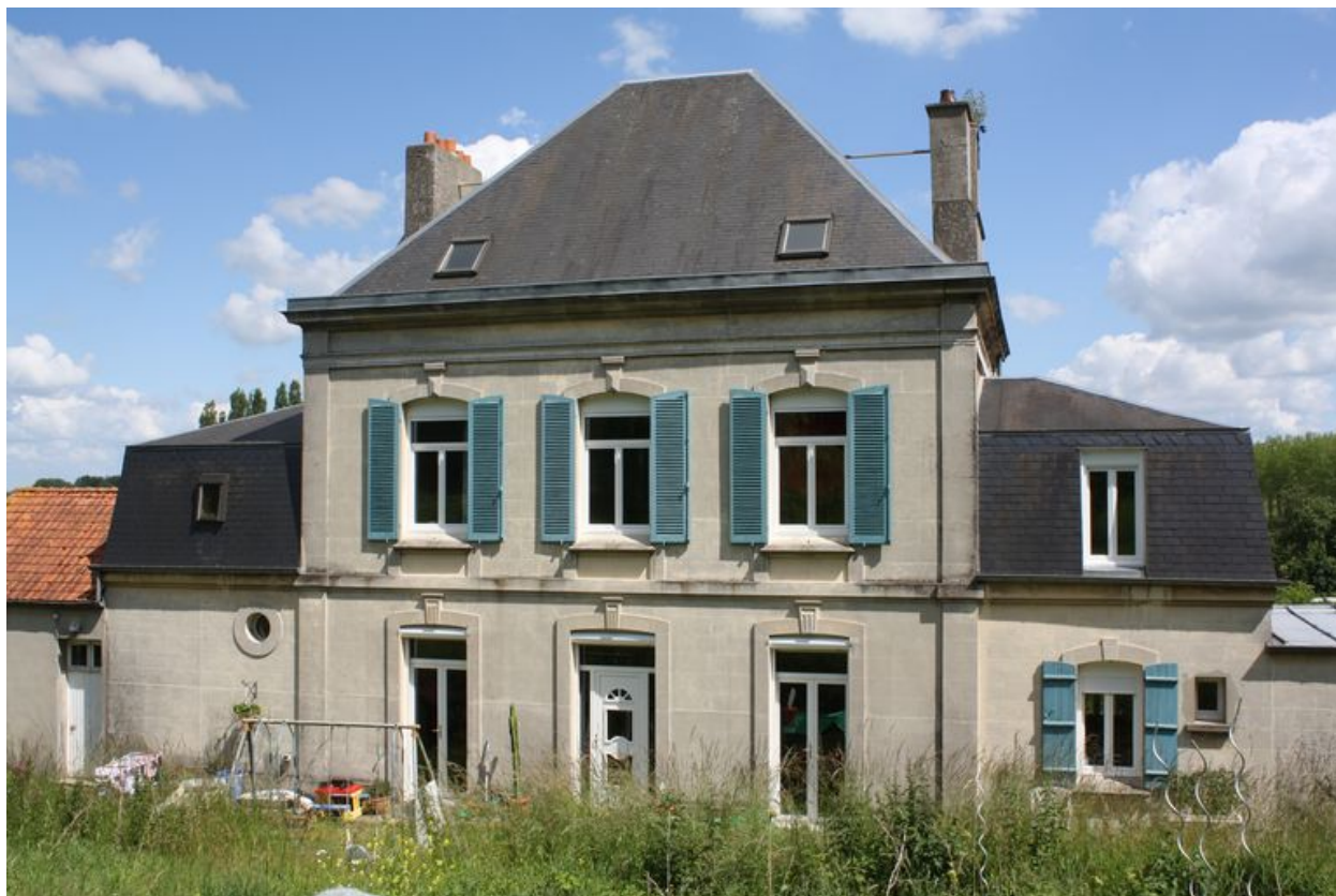
Elévation postérieure, sur jardin.
