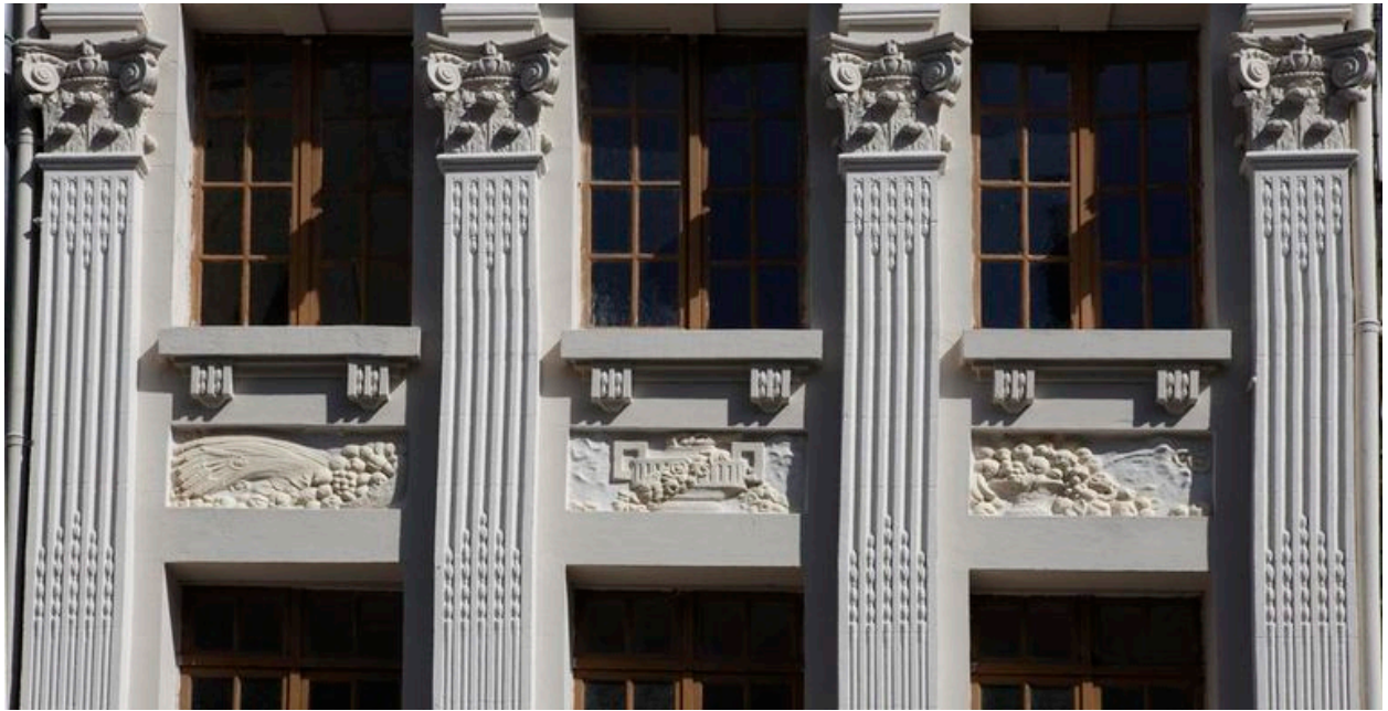
Ensemble des décors sculptés sur les pilastres et les allèges des baies.
