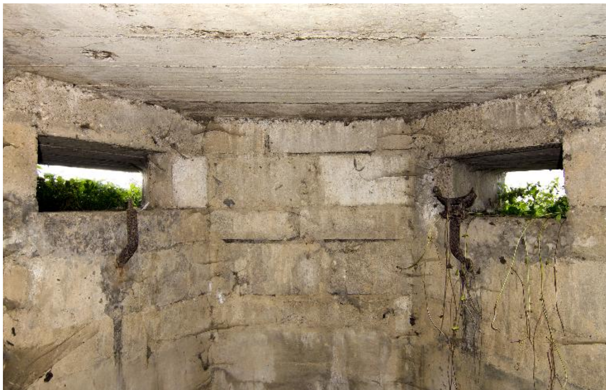
Vue intérieure de la tourelle sud
