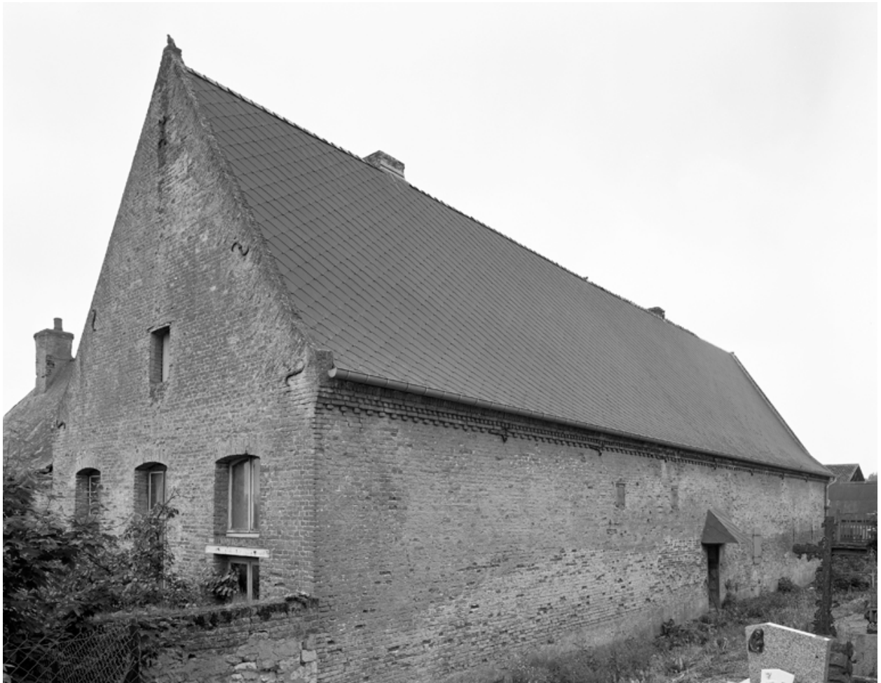
Logis prioral depuis le nord-est.
