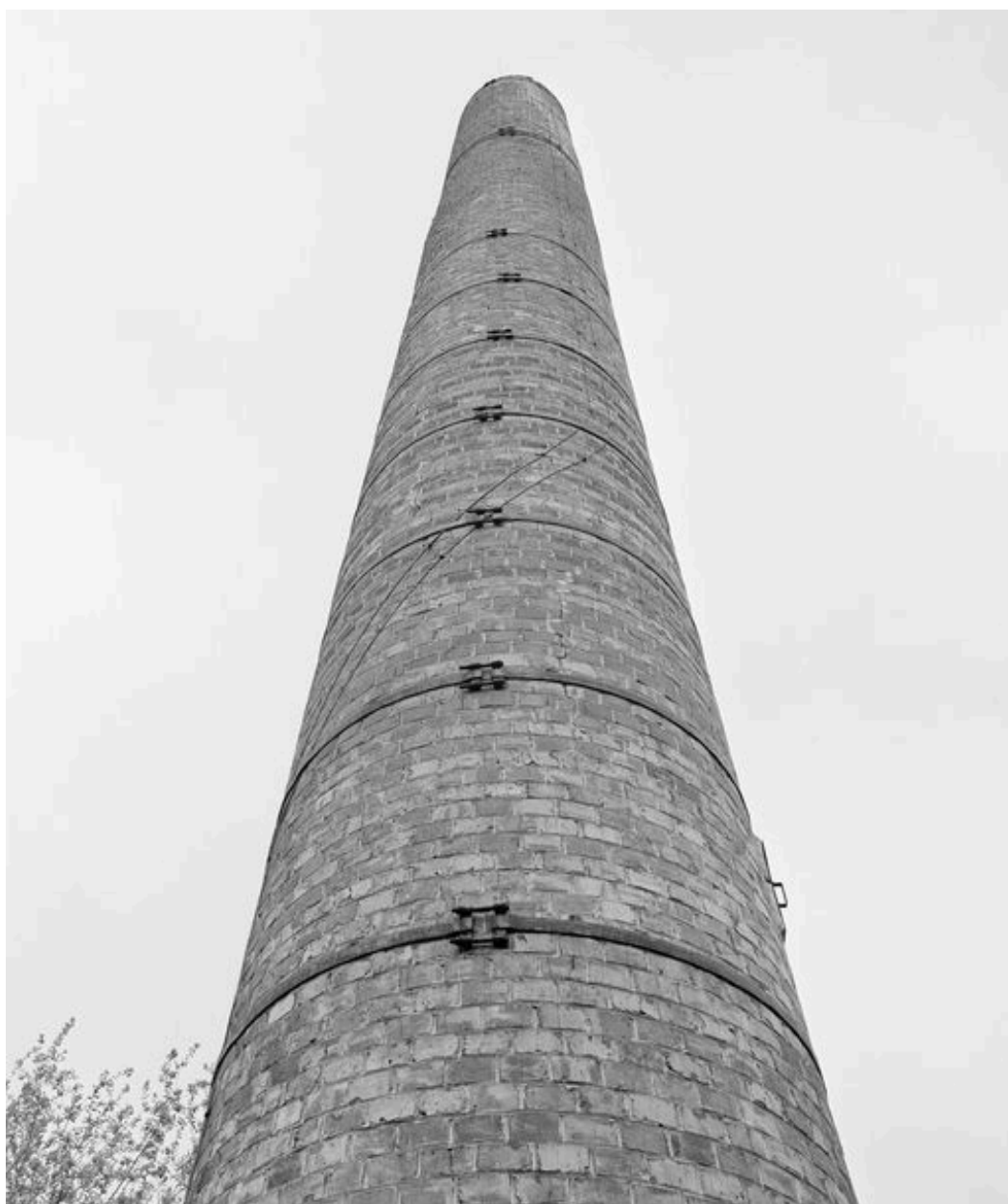
La cheminée d'usine.
