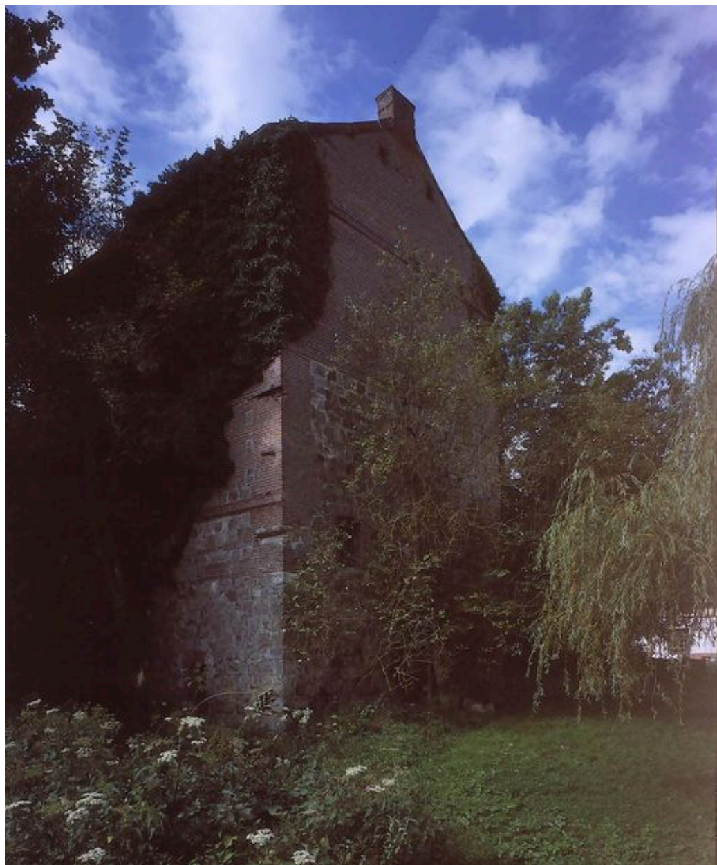
Pignon sur cour du moulin, vue d'ensemble.
