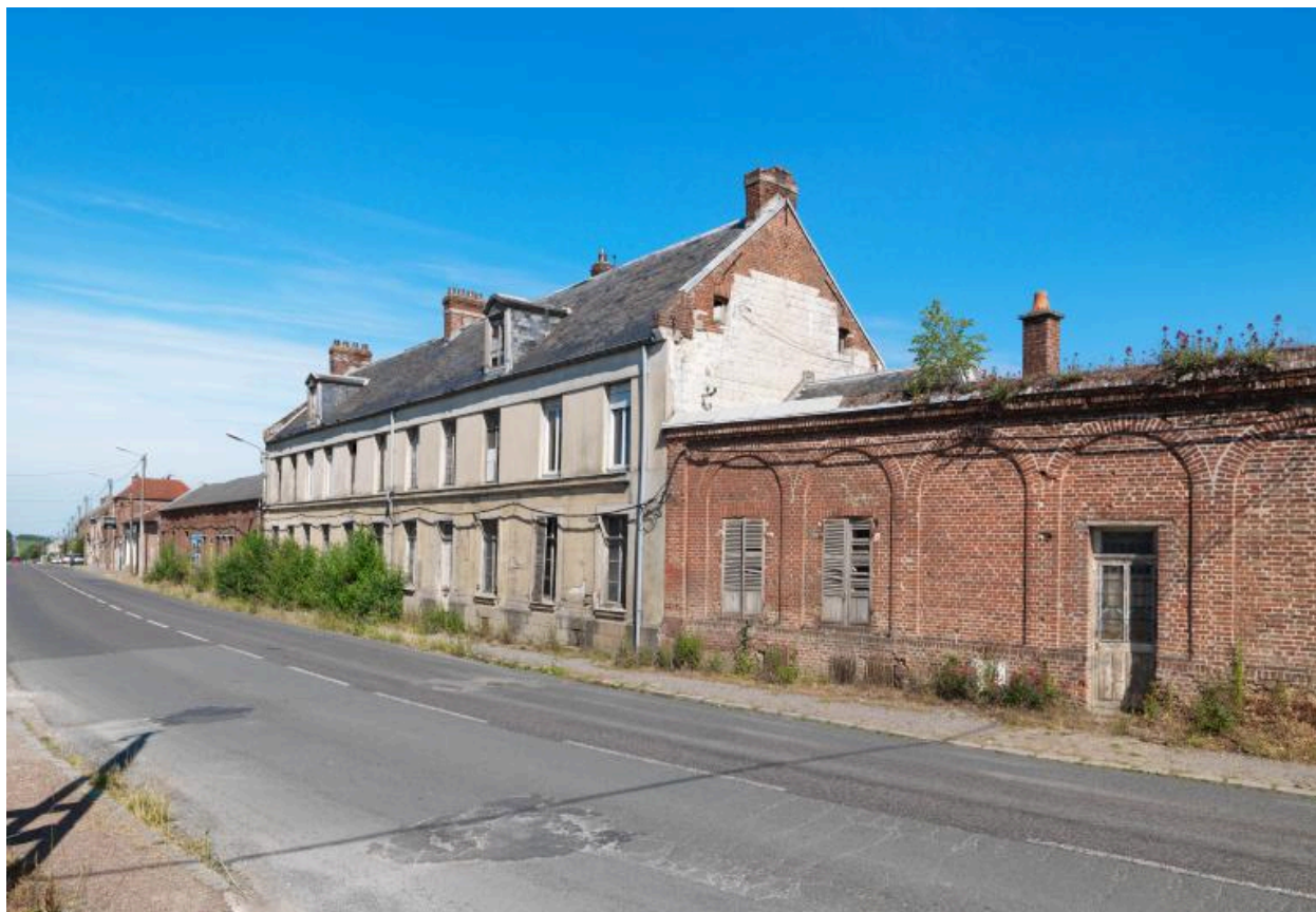
Vue des façades sur la route d'Amiens.
