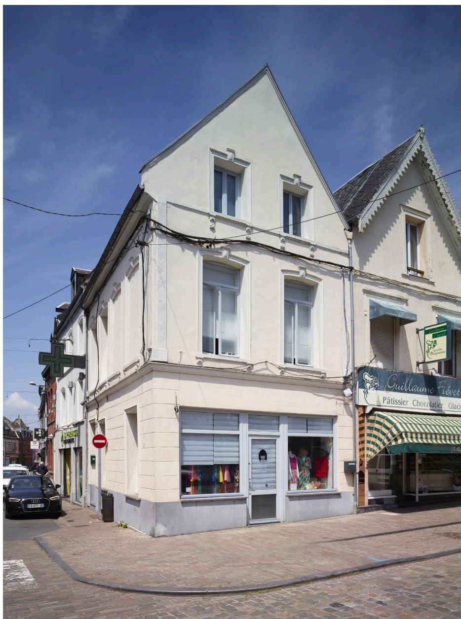
Maison à boutique - 22, rue Fournier : toiture à longs pans et pignon sur rue triangulaire, limite XVIIème - XVIIIème siècle.
