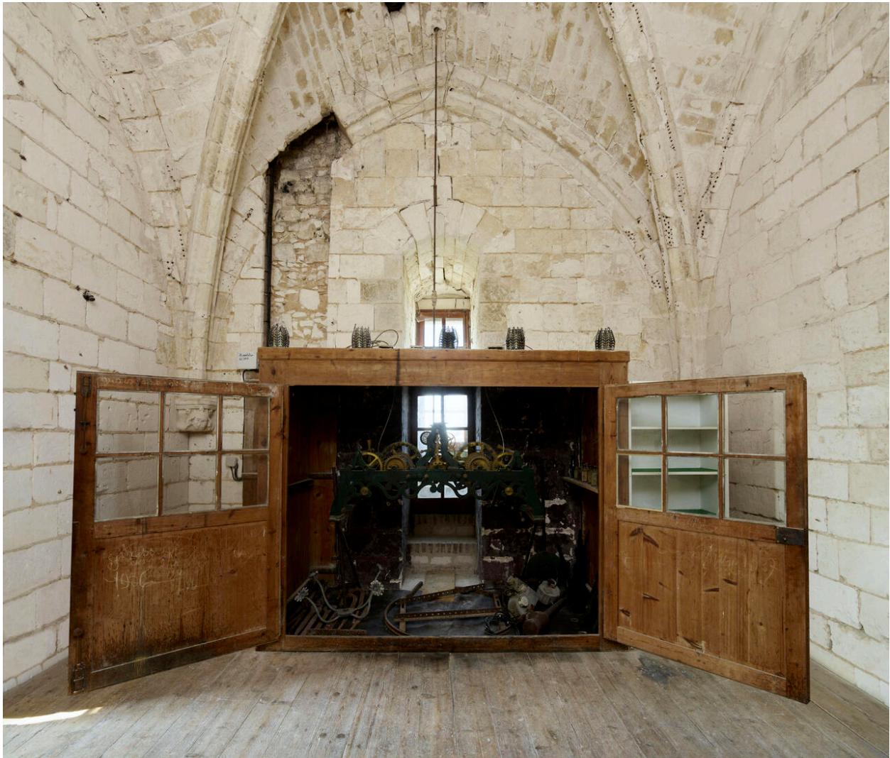
Armoire abritant le mécanisme des cloches, vantaux ouverts.
