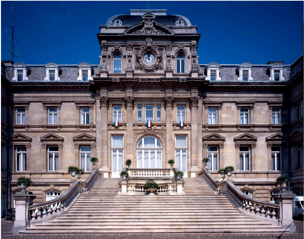
Façade principale donnant sur la place de la République, élévation du bâtiment fermant le fond de la cour d'honneur, vue générale.
