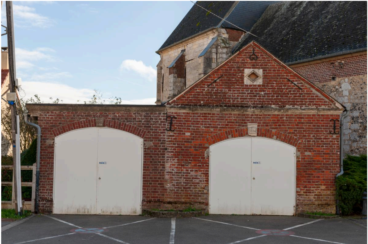
Remise des pompes à incendie, 1854 et 1954 (dates portées), vue depuis l'ouest.
