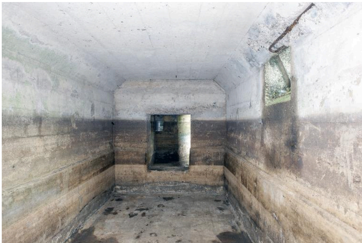
vue intérieure, salle ouest
