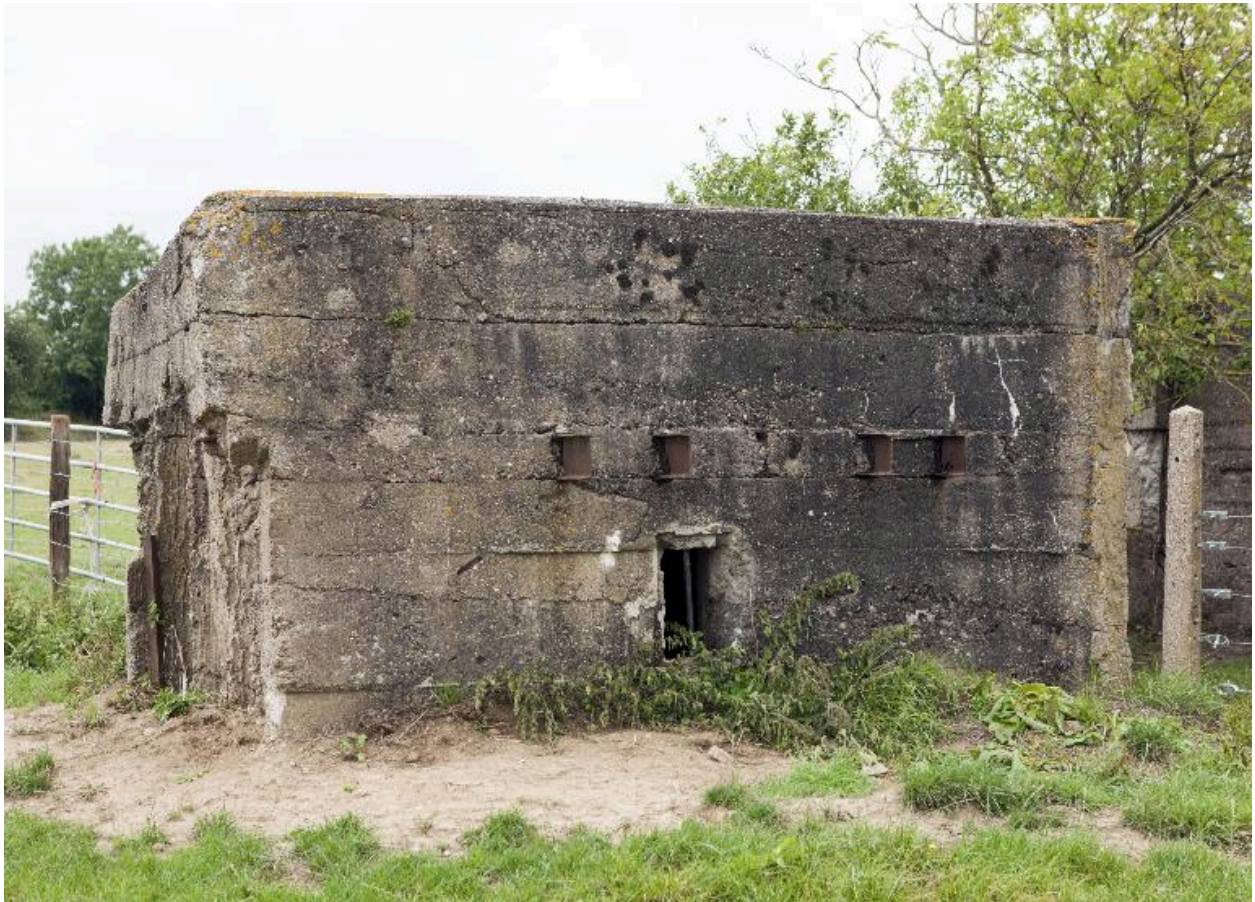
Partie sud de l'édifice, vers le nord-ouest
