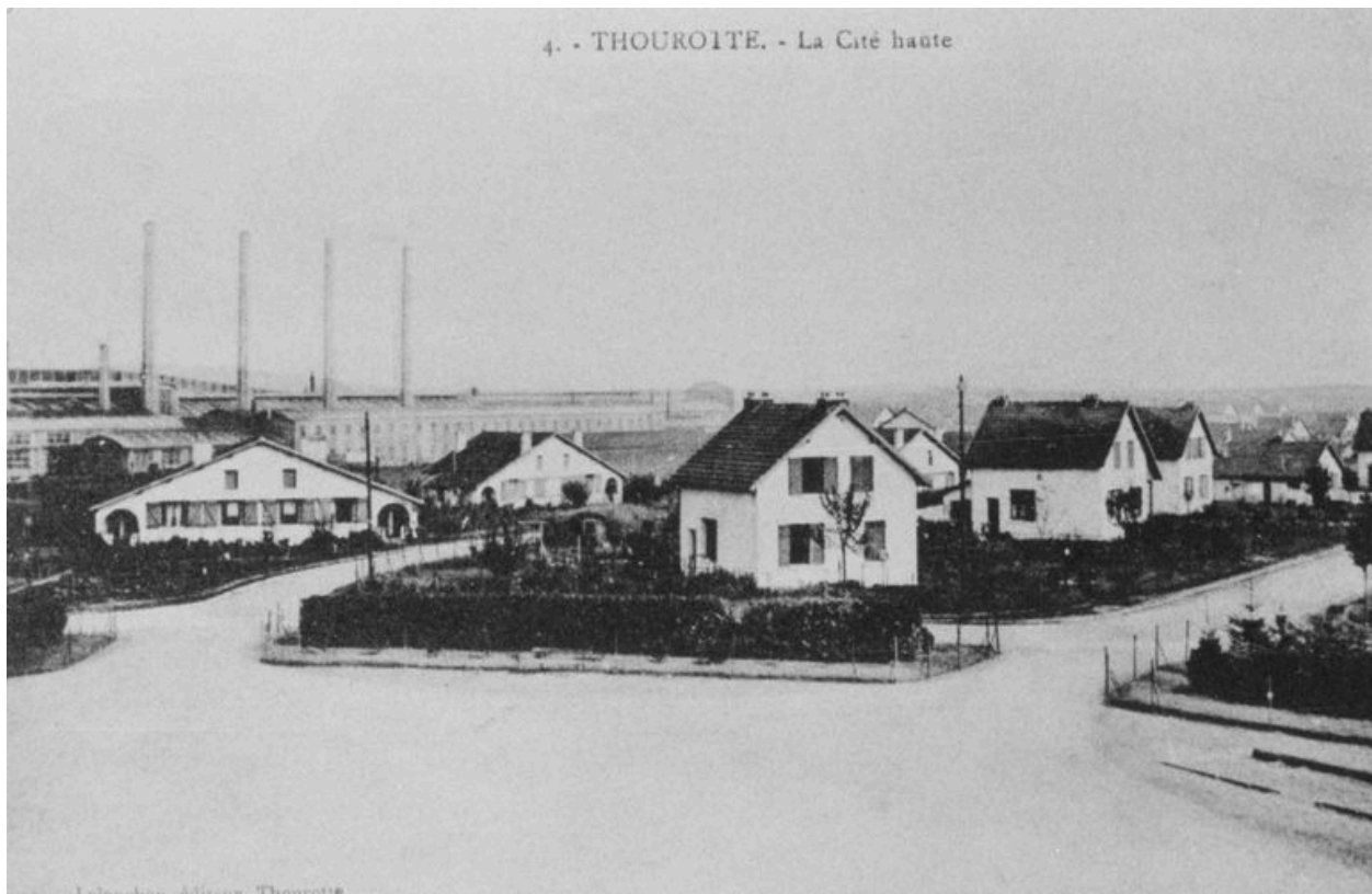
La cité ouvrière, dite cité Haute, avec à l'arrière plan, les bâtiments de l'usine, vers 1930 (AC Thourotte).
