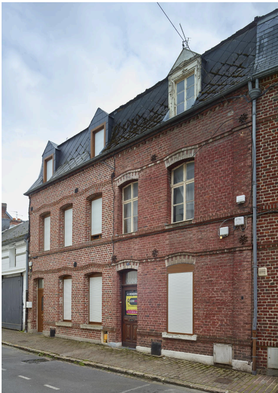
Maisons groupées du dernier quart du XIXe siècle - 3-5, rue Saint-François.
