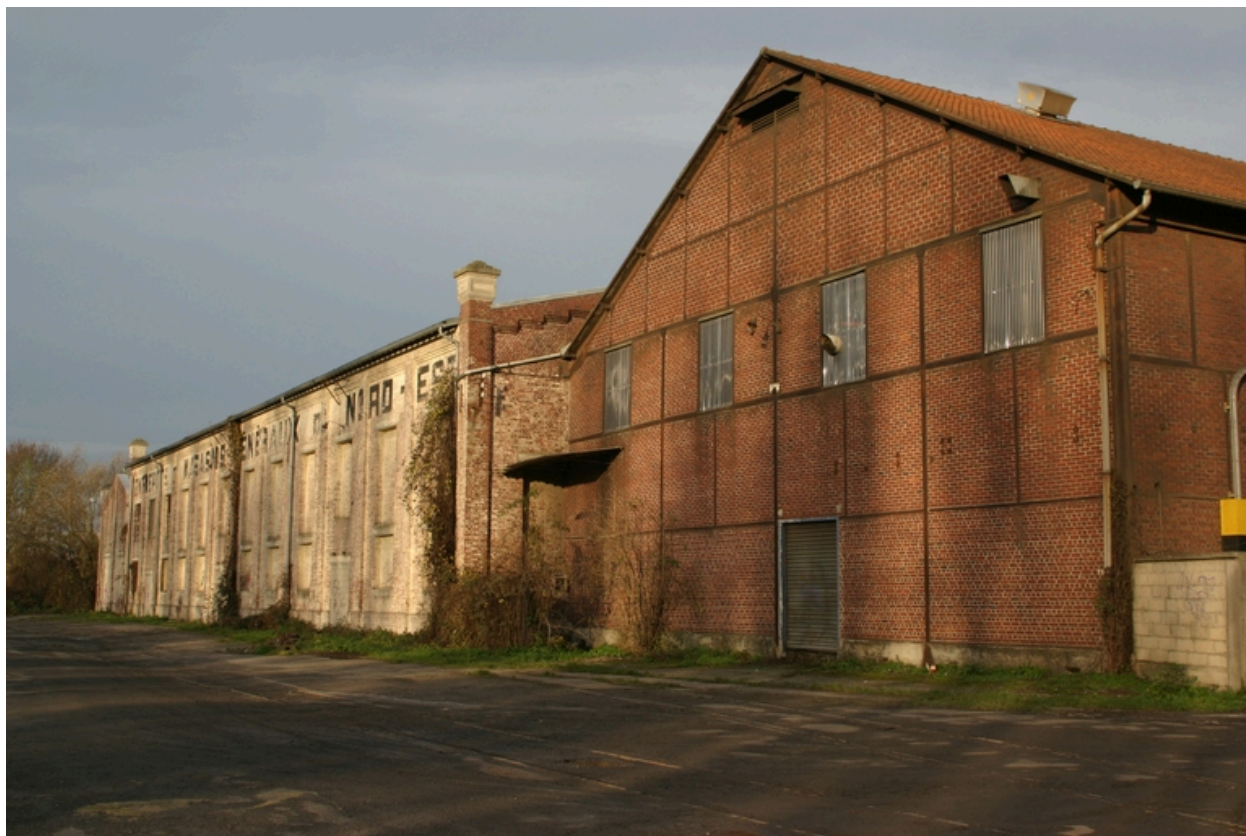
Façade des constructions de 1908 (à gauche) et de la reconstruction (à droite).
