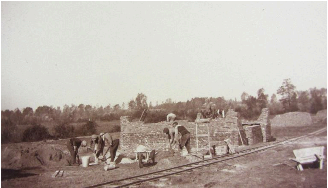
Edification des murs d'une des maisons de contremaître, 27 octobre 1920 (AD Somme ; 49 Fi 74).
