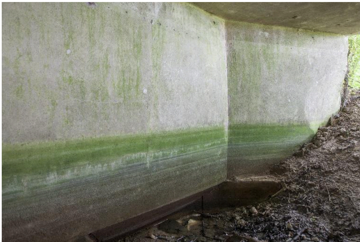
Chambre de tir. vers l'ouest.
