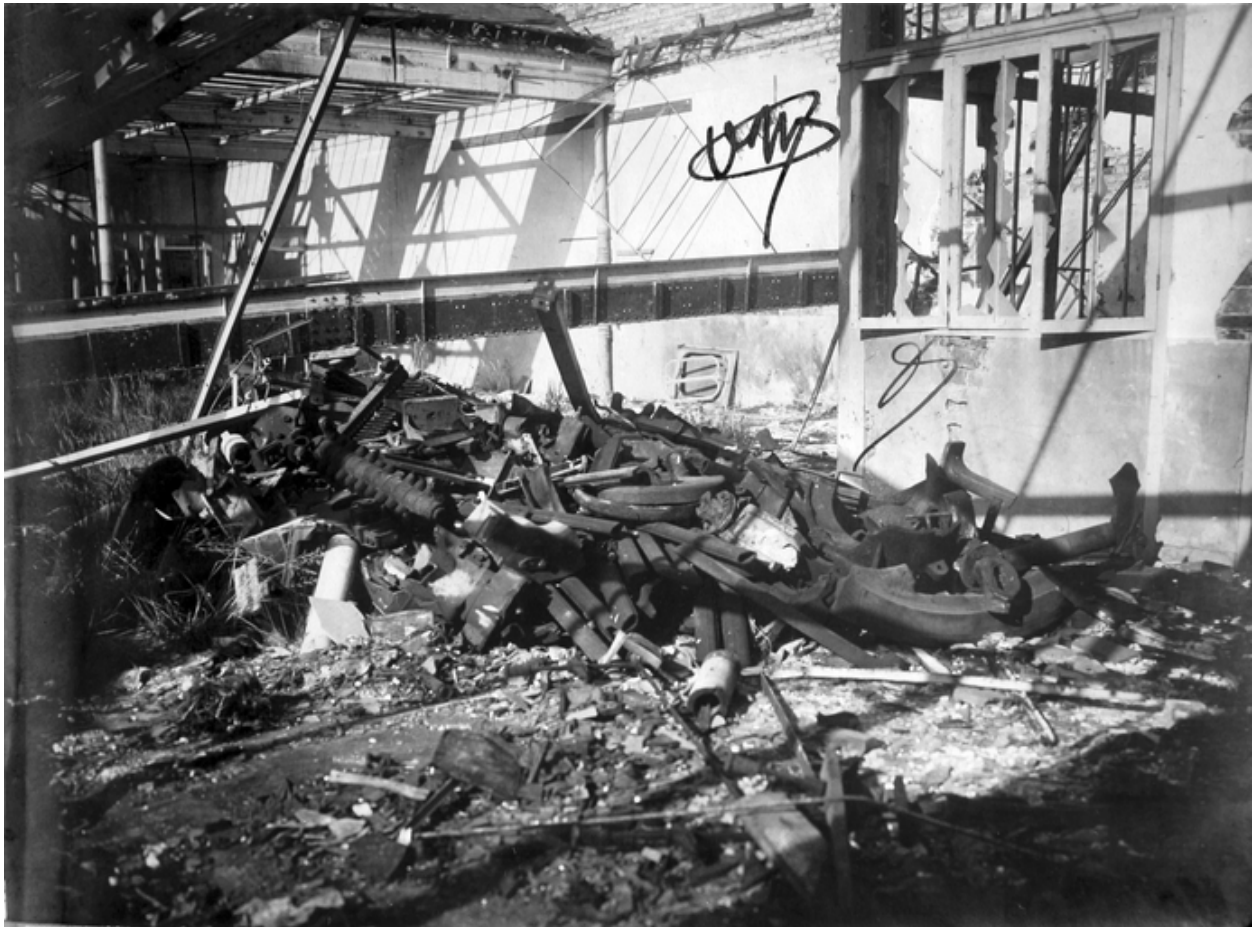
Eléments des moteurs, des métiers à tisser et des radiateurs de l'usine, vers 1919 (AD Aisne).
