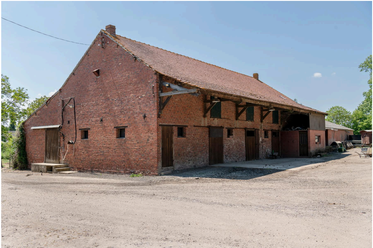
Vue des écuries prise depuis l'est.
