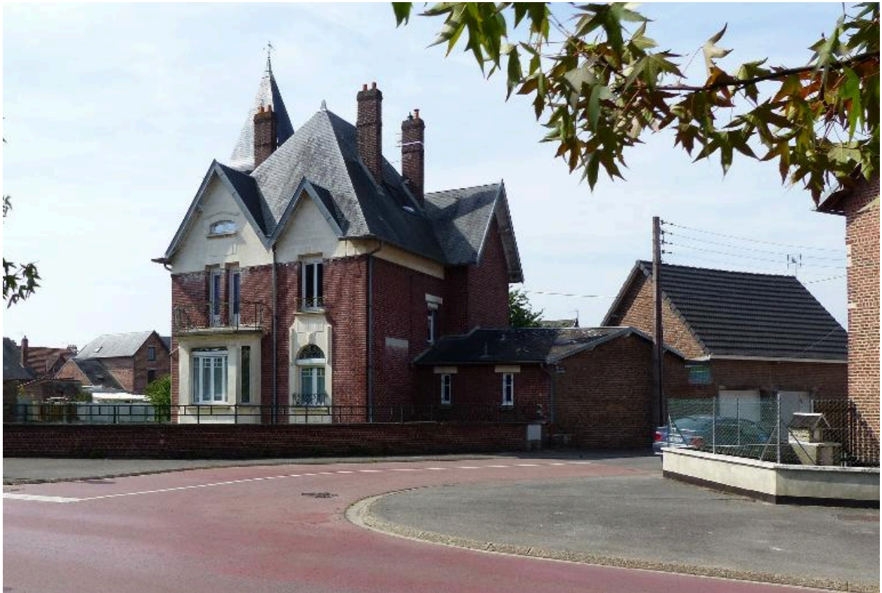
Vue de situation depuis le nord-est.
