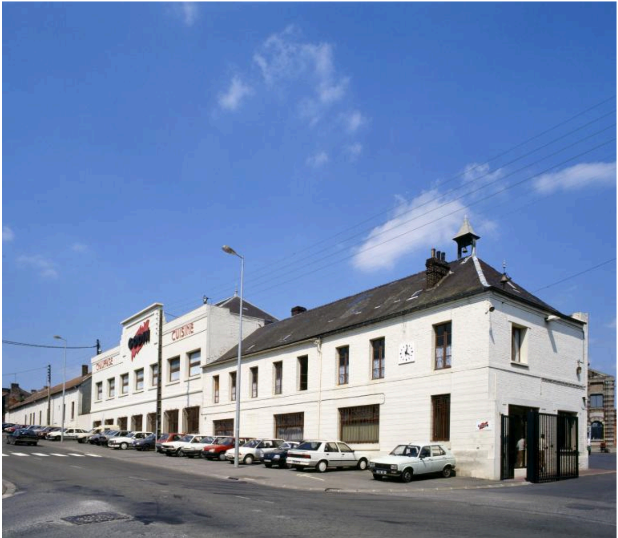
Vue d'ensemble des bâtiments administratifs depuis la rue.
