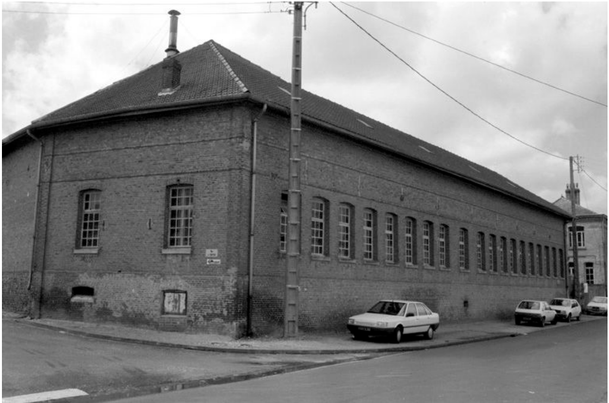
Élévation antérieure (flanc nord) des ateliers de fabrication.
