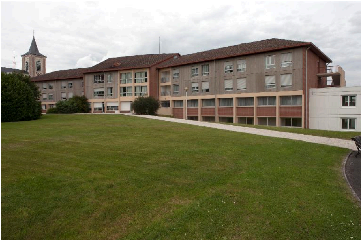
Vue générale de la résidence Saint-Martin (remplaçant l'ancien hospice).
