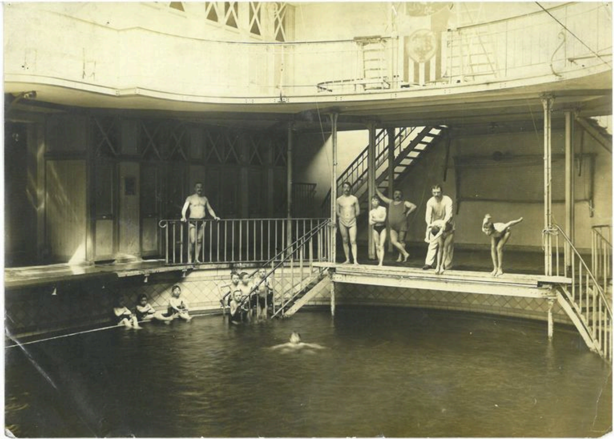
Détail du plongeoir situé côté grand bain, photographie (AC Tourcoing).
